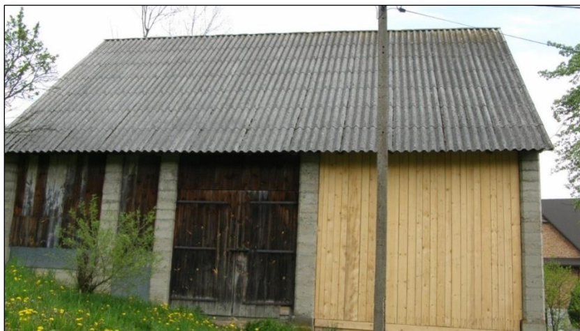
Rys. 6. Zdjęcie obrazujące wykorzystywanie wyrobów azbestowo-cementowych jako element pokrycia dachowego (eternit falisty), źródło: zdjęcie własne
